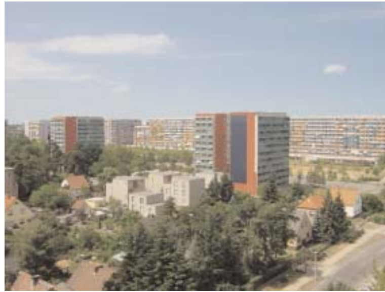
Konvertering av prefabhus till stadsvillor i staden Cottbus. Stadsvillorna har placerats i fotavtrycket på det nedmonterade prefabhuset. Arkitekt Zimmermann + Partner.
